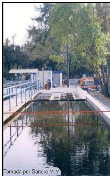
Figura 1. Tanque de Sedimentación del Tratamiento Secundario
