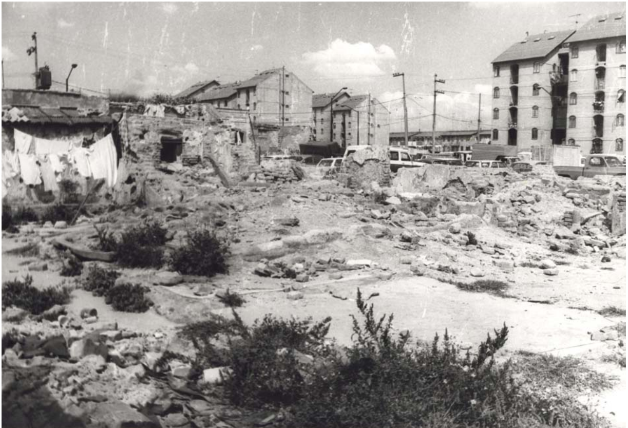
El sismo de 1985 pudo comprobar la resistencia de los nuevos edificios que construyeron con el Plan Tepito.
