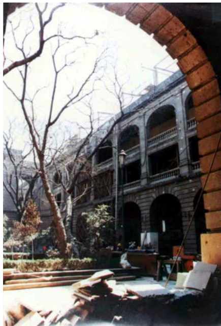
Restauración patio del trabajo
