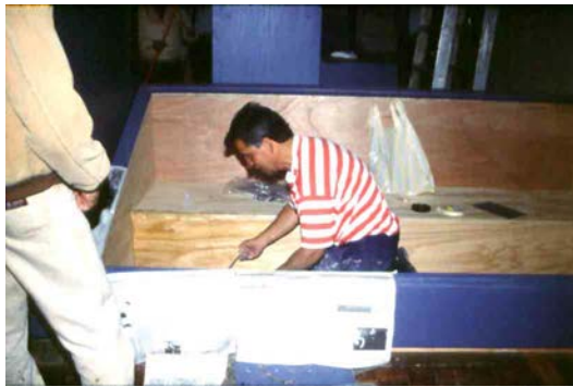
Trabajos de carpintería en vitrinas
