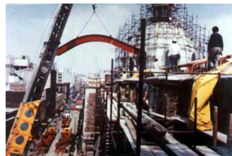
Restauración de Mampostería de Cúpula del Ex-Templo Encarnación
