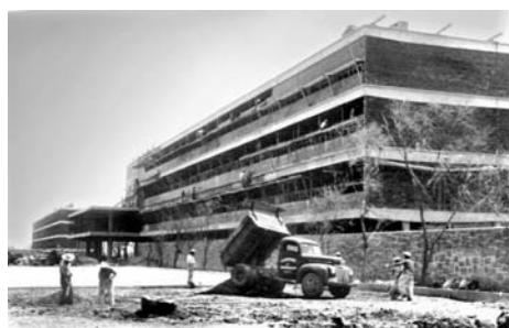
Construcción del edificio de la Facultad de Derecho en Ciudad Universitaria.
