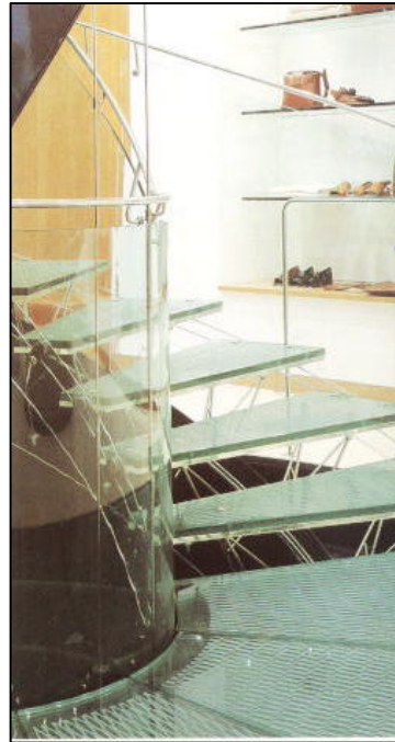
Detalle apoyo de las huellas
