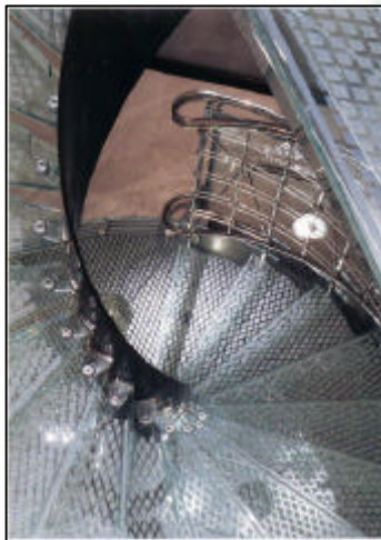
Detalle apoyo huellas
