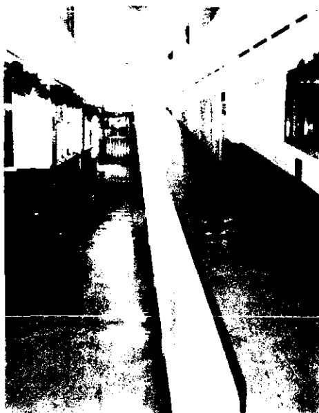
Rampas en las instalaciones de APAC
