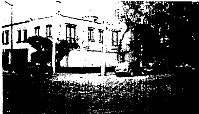
CALLE DEL CENTRO HISTÓRICO (CASA TIPO COLONIAL)
