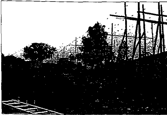
Figura 5.1 La foto muestra parte de la estructura del arreglo prototipo para estudios de CIP en el Observatorio Geomagnético de Teoloyucán Edo. De México.
