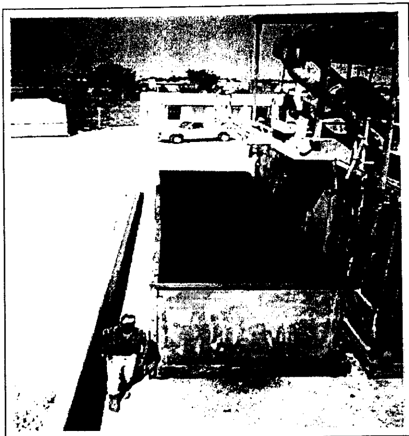
Fig. IV.7. Plancha de Cemento para cualquier Derrame, se quede ahí y luego se limpie, Compañía Baker Hughes (INTEQ), Reynosa, Tamaulipas.
