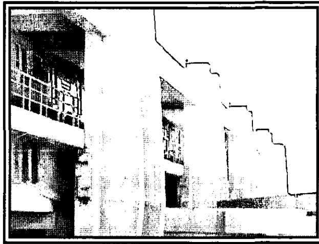
Figura I.9 Columnas de la Estación
