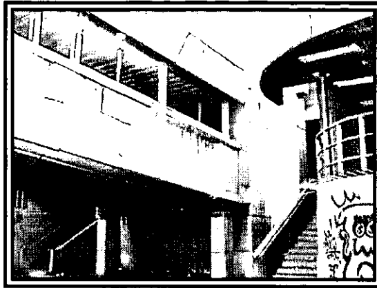
Figura I.6 Apoyo de la Pasarela II con Línea 9
