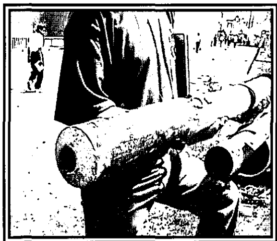
Figura II. 22 Muerto del Banco de Nivel Profundo
