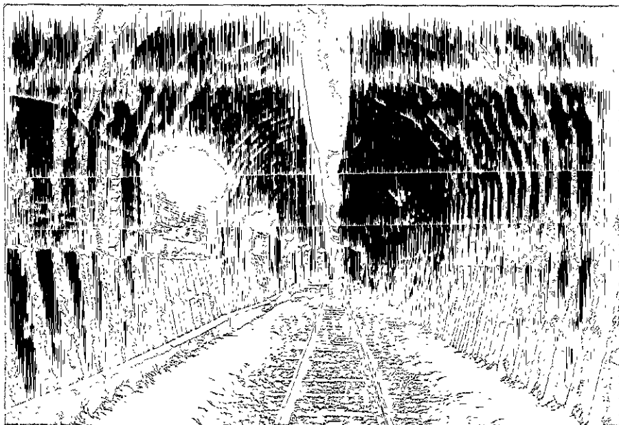
Vista del túnel 5 excavado por el método convencional en sección herradura.
