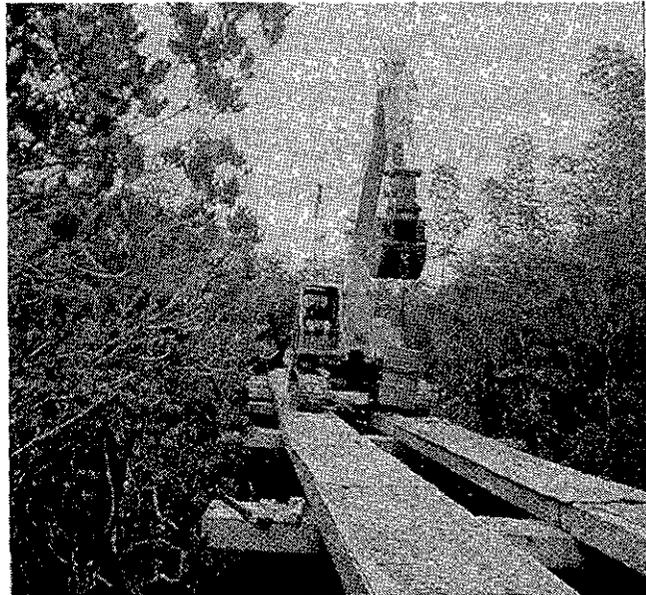
Figura 3.8 Camino de acceso temporal para personal y maquinaria, en la construcción de una línea de transmisión, Powerlink - Queensland's, Australia- [1].
