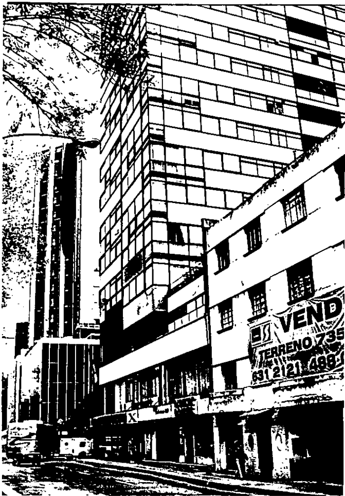
Lateral de Av. Paseo de la Reforma, vista desde la Diana hacia el Ángel y desde la Diana hacia el predio del proyecto arquitectónico.
