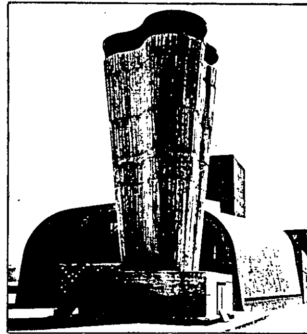
Fig. 9 . Le Corbusier. Unidad habitacional. Marsella. Detalle de techo. El techo está diseñado, con la monumental torre de ventilación en forma de trébol y servicios que forman parte de la forma arquitectónica.
