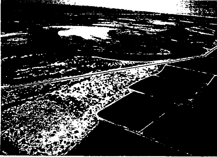
FOTO 21. Recubrimiento marginal colocado para proteger el canal. Se prolongó con un dique. Nótese la vegetación que ha crecido en los depósitos aguas abajo de la protección.
