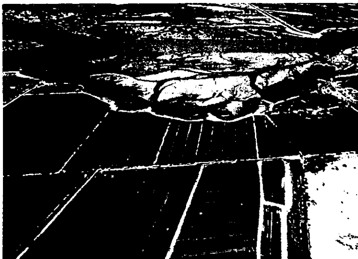
FOTO 3. Al moverse el río aguas arriba cambió la dirección del flujo frente a la curva protegida. Los espigones ya no trabajan, aunque podrían hacerlo si se incrementa el gasto.
