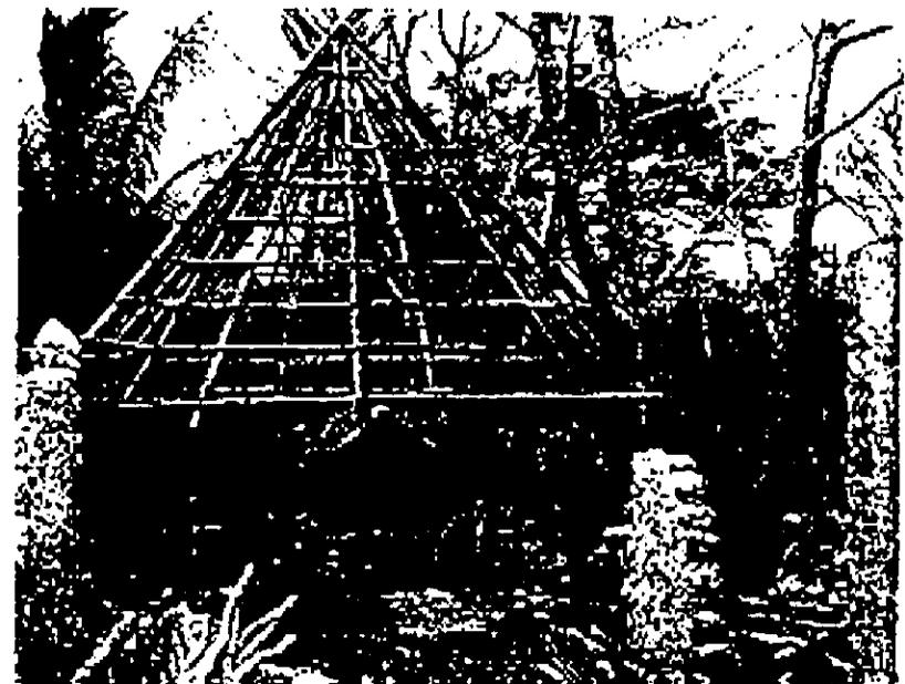
Fig. 4.3.3. Detalle de armado de techo cónico.
