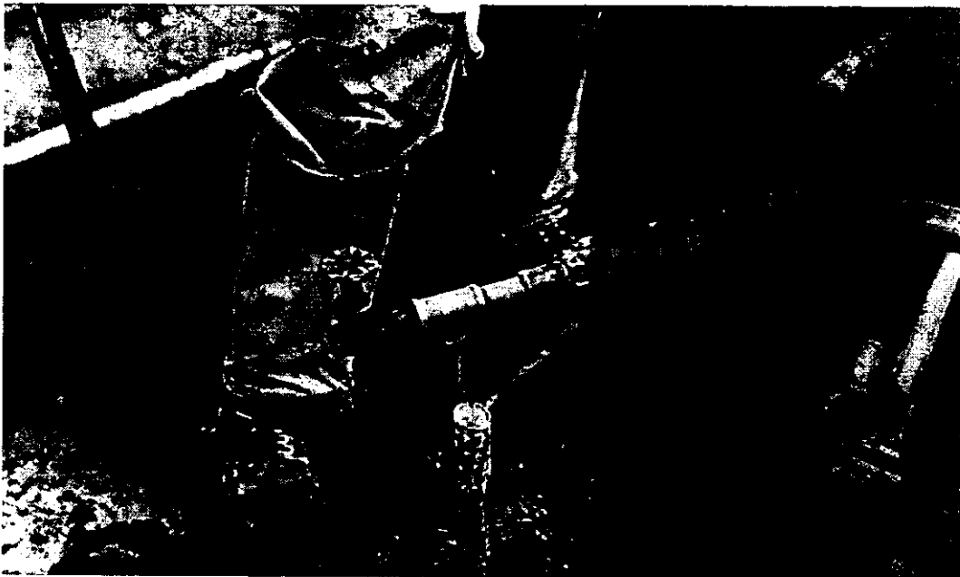
Figura 6.19. Vista de la tubería de inyección en la entrada del manguito.
