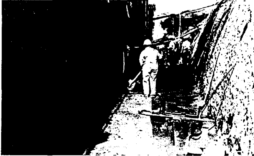
Figura 5.54. Trabajos del relleno de compactación.
