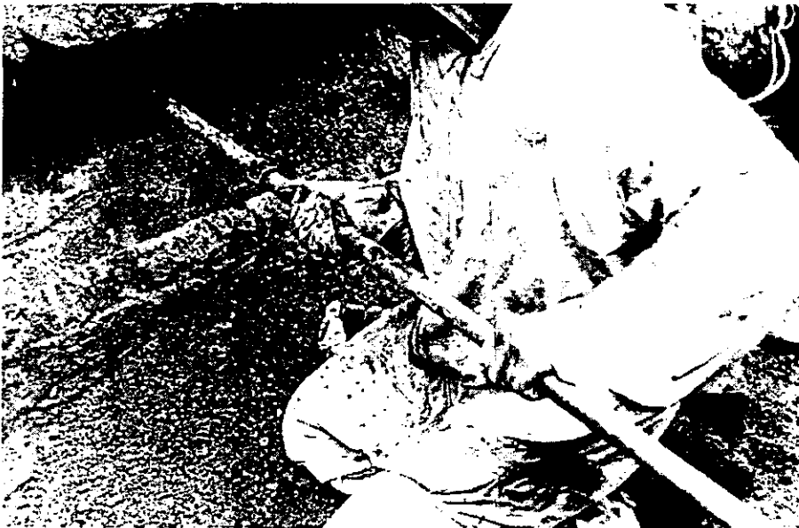
Figura 5.37. En la primera etapa de subexcavación la herramienta utilizada fue manual.
