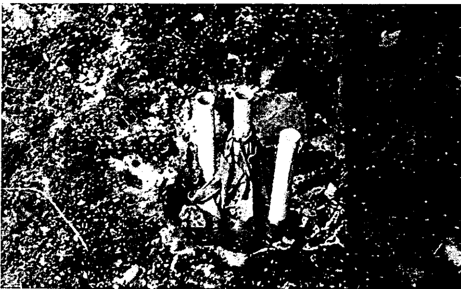
Figura 6.17. Manguitos colados y vistos después de la inyección.
