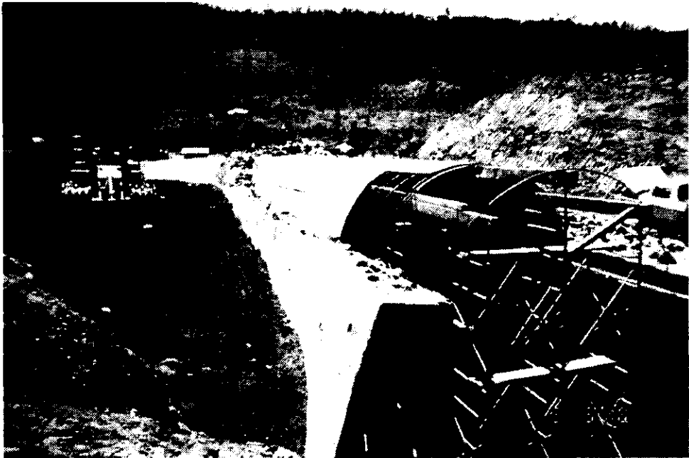
Foto 4.9 Alcantarilla de bóveda.
